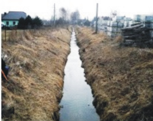
Km 1+930 Kanał ziemny umocniony, prosty o stałym przekroju, na brzegach roślinność niska.
