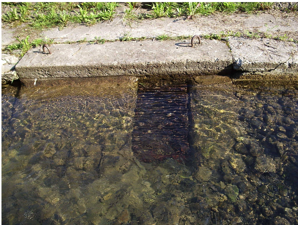
Fot. 9.1. Krata zabezpieczająca wlot ujęcia brzegowego
