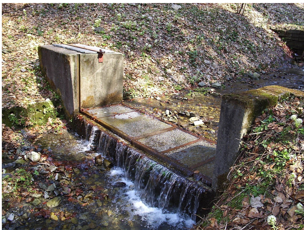
Fot. 9.6. Ujęcie progowe na potoku Pisarzówka
