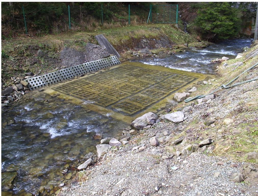
Fot. 9.3. Ujęcie infiltracyjno-poddenne na potoku Cięcinka
