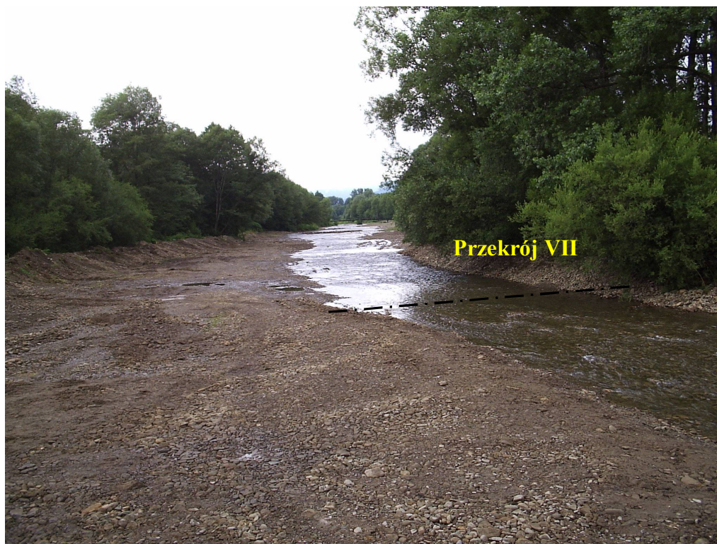
Fot. 3.3. Przekrój badawczy VII na potoku Leśnianka powyżej ujęcia wody
